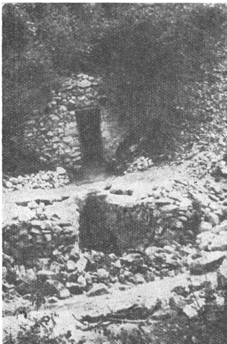
1. ábra. Mészégető gödör mögé épített kőfalú kunyhó, Cserépfalu. (A fényképeket a szerző készítette)
