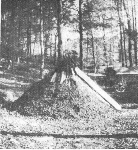
10. ábra. Kerek kunyhó, oldala részben földelt, bejáratát a jobb oldalon deszka takarja. Répáshuta
