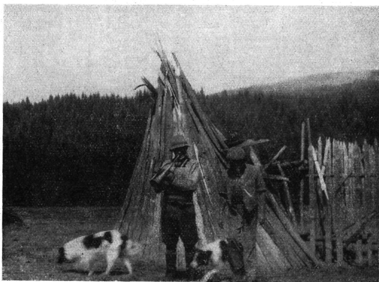
4. ábra. Szálfa- és kéregborításos juhászkunyhó. Gyimes. Kallós Zoltán felvétele, 1961. F. 212.711
