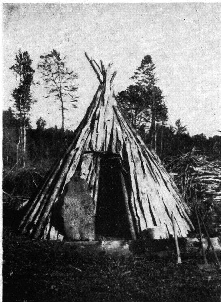
2. ábra. Szálfaborításos szénégető-kunyhó. Székelyvarság Tagán Galimdsán felvétele, 1941. F. 88.835
